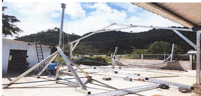
Foto 1: INICIACIÓN Y COLOCACION DE LAS TIJERAS PARA EL ENTECHADO.
