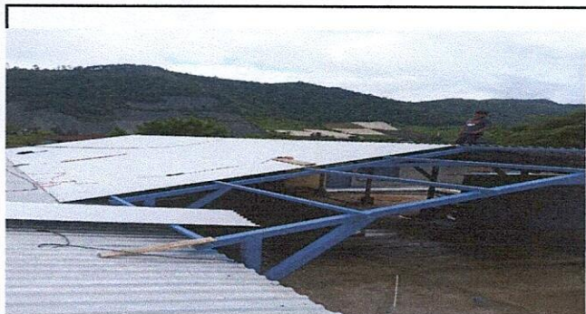
Foto 3: INSTALACION DE LÁMINA DEL ENTECHADO.
