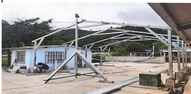
Foto 2: CONTINUACION DE LA INSTALCION DE LAS TIJERAS PAR EL ENTECHADO.
