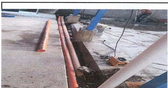
Foto 4: FUNDICION LINEAL E INSTALACIÓN DE TUBERÍA DE DRENAJE PLUVIAL.
